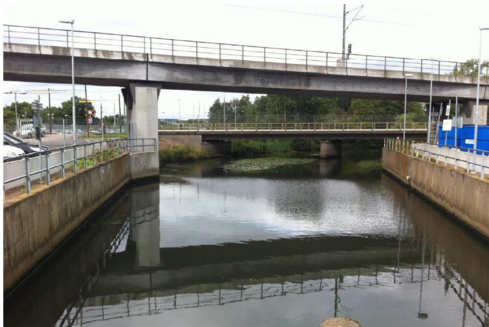
Figur 2: Gullbergsån vid utloppet för den mycket långa kulverten.
