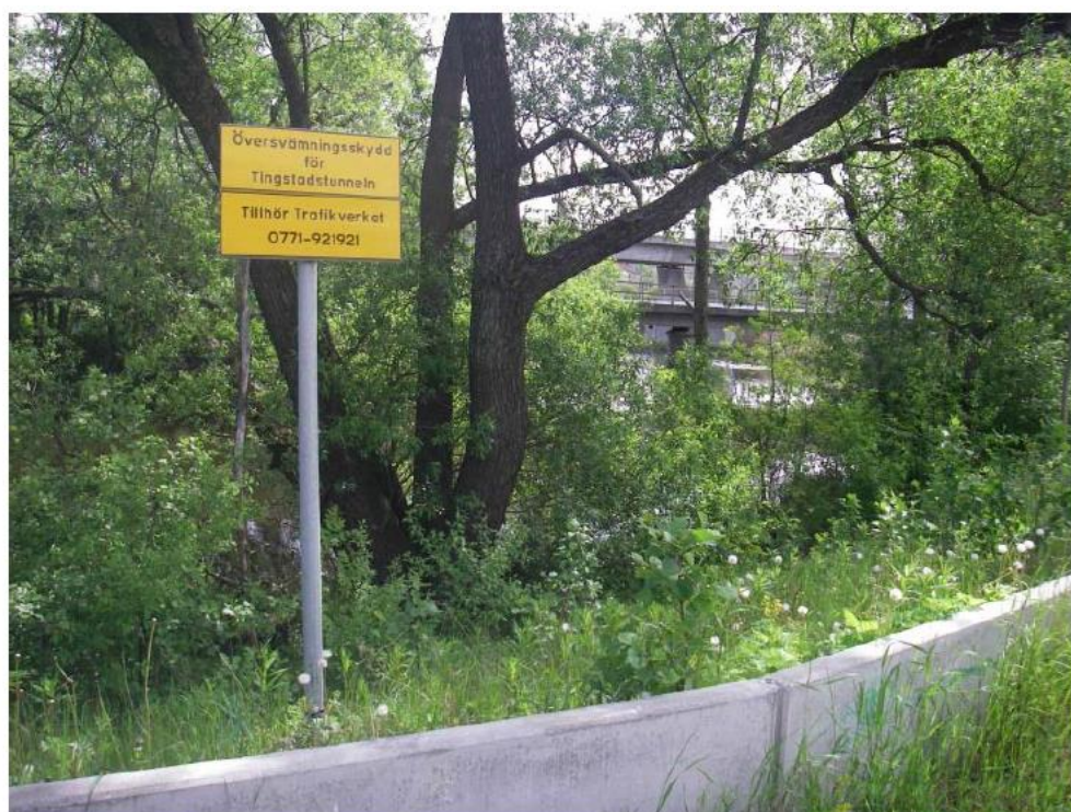
Figur 10. Del av dagens översvämningsskydd utmed Gullbergsån
